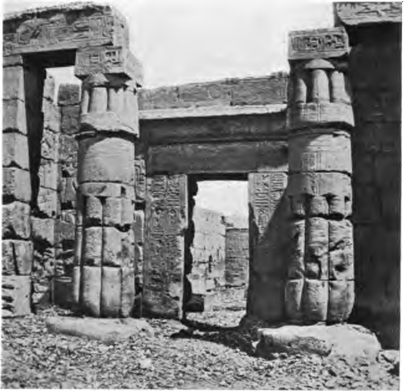
Fig. 54. — Porte à linteau et à piédroits monolithes au temple de Gournah (Égypte).
